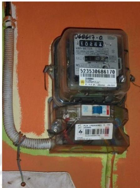
Gambar. 2.3 KWH Meter dilengkapi kawat segel
