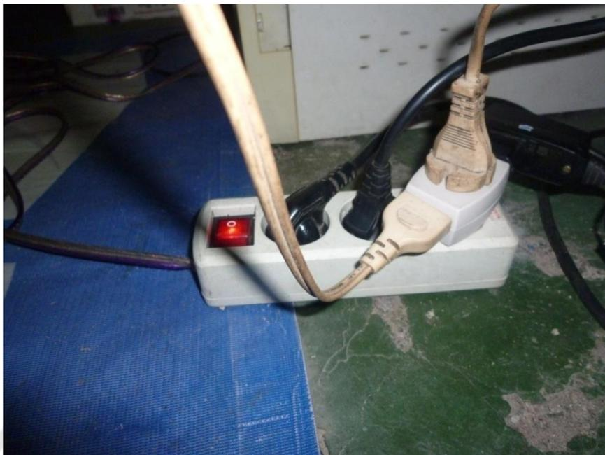
Gambar 2.9 Menumpuk kontak tusuk/steker pada satu sumber listrik
