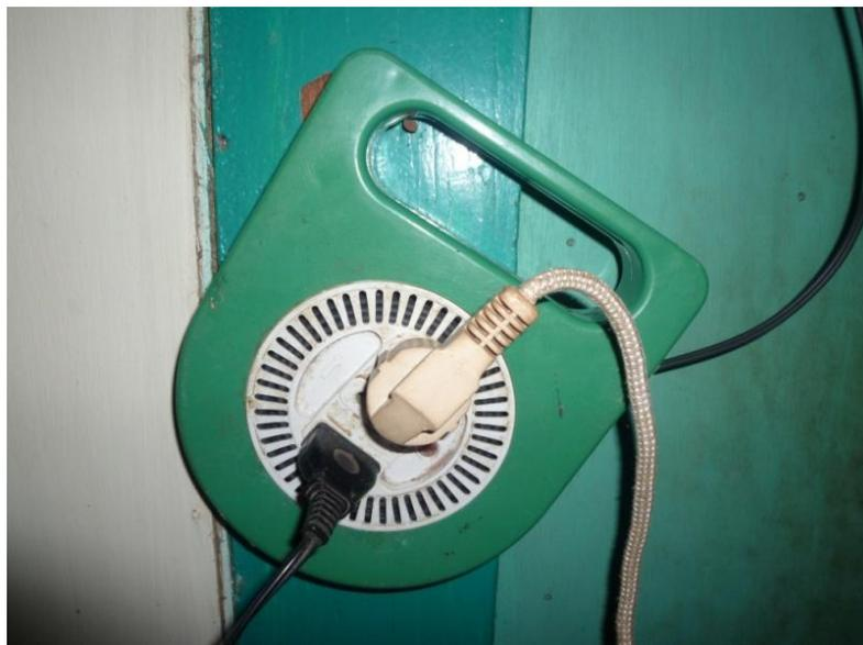
Gambar 2.7 Sebuah Stop kontak yang tidak standar
