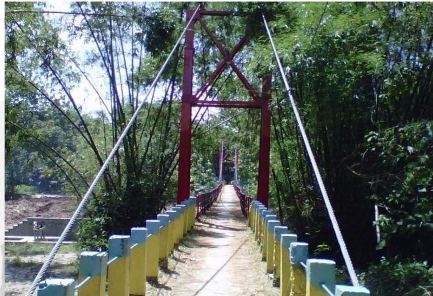
Gambar 4.3. Jembatan Gantung di Desa Karas Kepoh (sumber: dokumentasi pribadi, diambil tanggal 22 April 2013)
