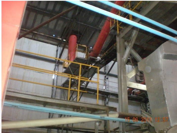
Dokumentasi I Observasi lingkungan pabrik (atap terbuat dari seng)
