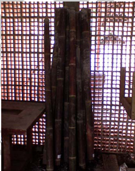
Gambar 4 Bambu Setelah Diisi Mortar
