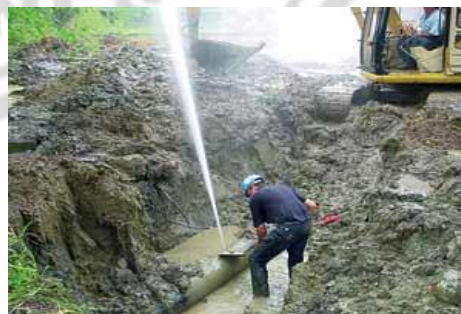
Gambar 2.1 Ilustrasi kebocoran pipa yang sering terjadi di lapangan.
