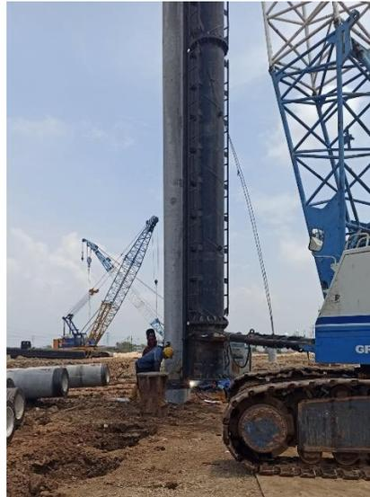
Gambar 2.11 Proses pemasangan tiang pancang untuk pondasi jembatan (PT Wijaya Karya Persero Tbk, 2022).
