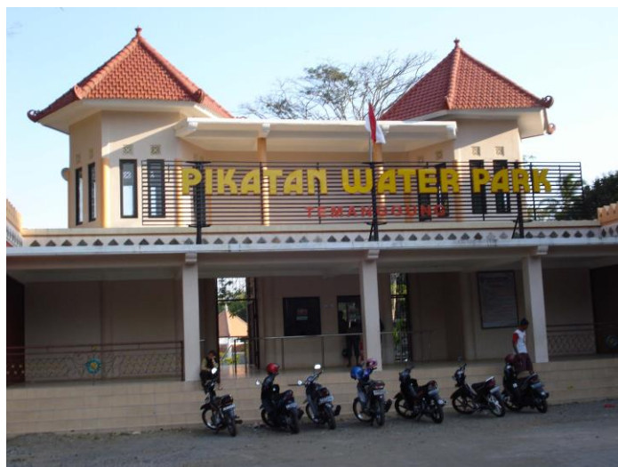
Gambar 5.3.a Pintu Masuk Obyek Wisata Pikatan Water Park
