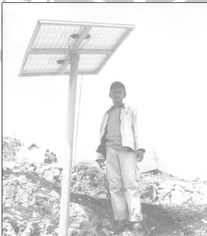
Gambar 27. konstruksi pemasangan solar sel 4 blok berdaya masing-masing 50 W
