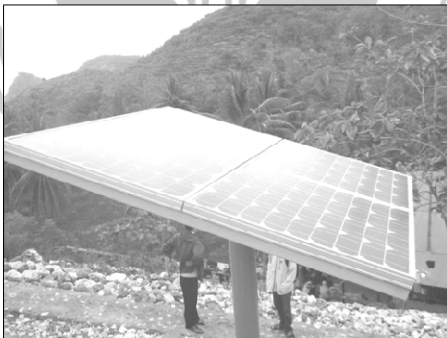
Gambar 26. penampang solar sel berkekuatan 200 Watt
