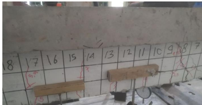
Gambar 4.19 Pola Retak Balok Kontrol
