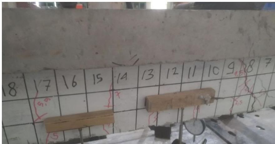
Gambar 4. 18. Pola Retak Balok Kontrol
