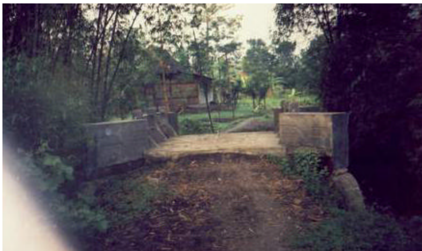
Gambar 5. Jembatan desa sesudah dibangun Sumber: Photo diambil selama penelitian berlangsung
