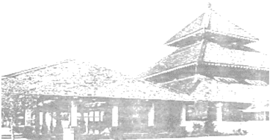
Gambar 9. Masjid Agung Demak yang dibangun oleh Raden Patah tahun 1466 (Sumber: Pinterest, 2018)
