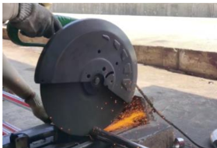
Gambar 6.2 Pemotongan pipa menggunakan gerinda potong
