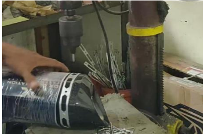
Gambar 6.41 Proses bor untuk pemasangan list cover
