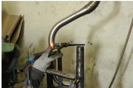
Gambar 6.19 Pengelasan sambungan pipa
