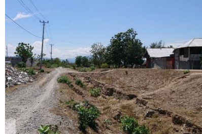
Foto 1. Setelah gempa (dilihat dari Selatan)
