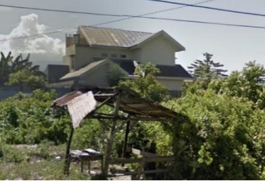
Foto 9. Sebelum gempa (dilihat dari Barat Daya)
