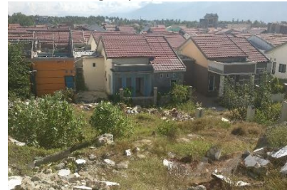
Foto 10'. Setelah gempa (dilihat dari Barat Daya)
