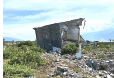
Foto 8'. Setelah gempa (dilihat dari Timur)
