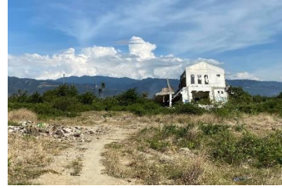
Foto 7'. Setelah gempa (dilihat dari Timur)
