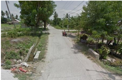
Foto 4. Sebelum gempa (dilihat dari Barat Daya)
