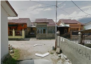
Foto 10. Sebelum gempa (dilihat dari Barat Daya)
