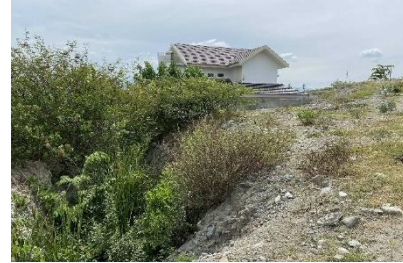
Foto 9'. Setelah gempa (dilihat dari Barat Daya)
