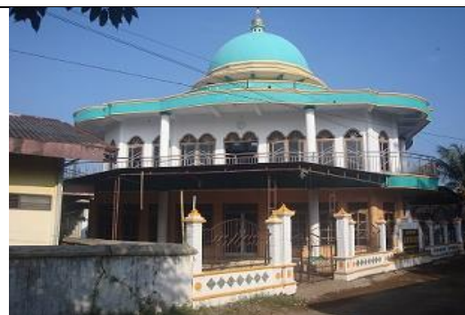
Gambar 4.6 Masjid Nurul Falah Banyutowo Sumber : banyutowo-dukuhseti.desa.id
