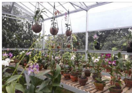
Gambar 1. Green House yang telah dibangun oleh Phapros
