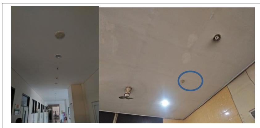
**Gambar 4.8** Detektor, springkler, dan penerangan darurat Gedung Komprehensif (Kiri) dan detektor panas di Instalasi Gizi
