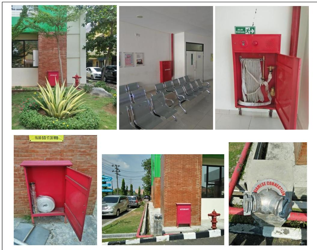
**Gambar 4.9** Kotak Selang, Penghubung Siamese dan Hidran dalam dan luar Gedung Komprehensif
