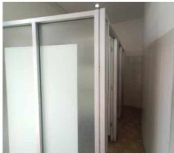
Toilet Area Pintu Masuk (Dalam)
