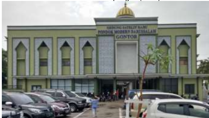
Gambar 2.72. Gedung Satelit penerimaan tamu OPPM Sumber: Survei Lapangan (2019)
