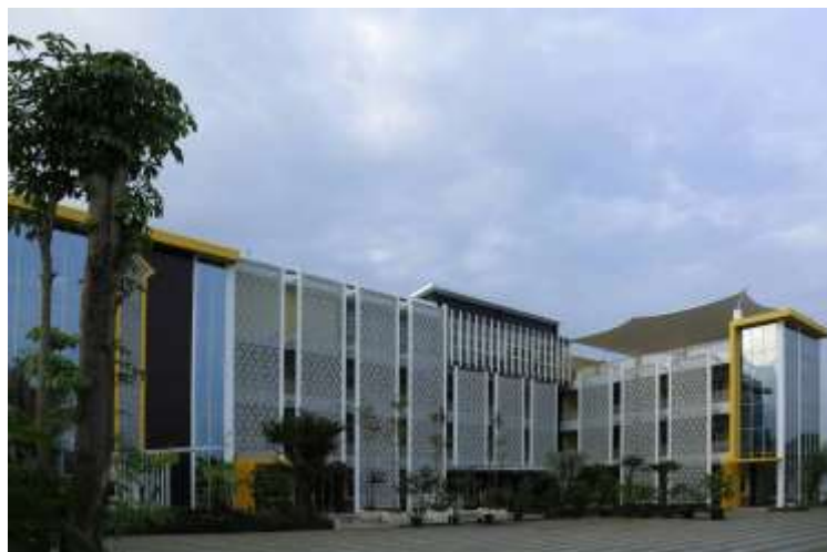
Gambar 2.80. Gedung Utama IBS Tazkia Kampus 2 Sumber: Survei Lapangan (2019)
