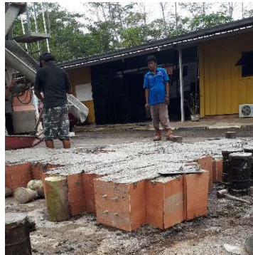
Gambar 3.6 Pengecoran Beton Ready Mix
