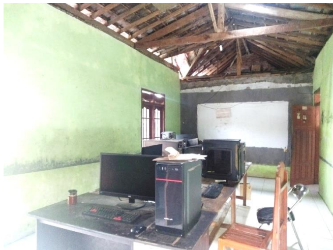
Gambar 7. Ruang Komputer (Sumber: Dokumentasi Pribadi Peneliti 2020)
