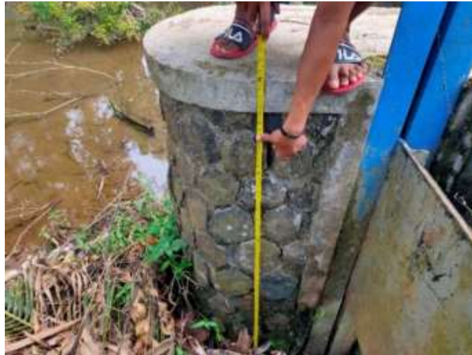
Gambar 3.2 Pengukuran Saluran Penampang 1 Sumber data : Dokumentasi
