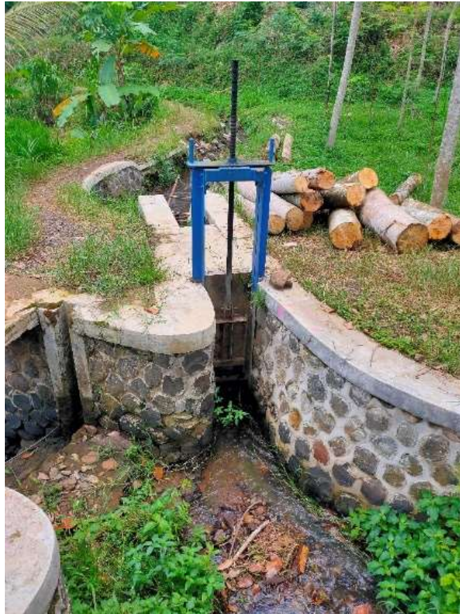
Gambar 3.5 Pengukuran Saluran Penampang 4 Sumber data : Dokumentasi
