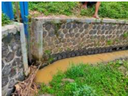
Gambar 3.4 Pengukuran Saluran Penampang 3 Sumber data : Dokumentasi
