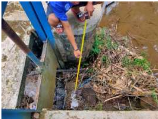
Gambar 3.3 Pengukuran Saluran Penampang 2 Sumber data : Dokumentasi
