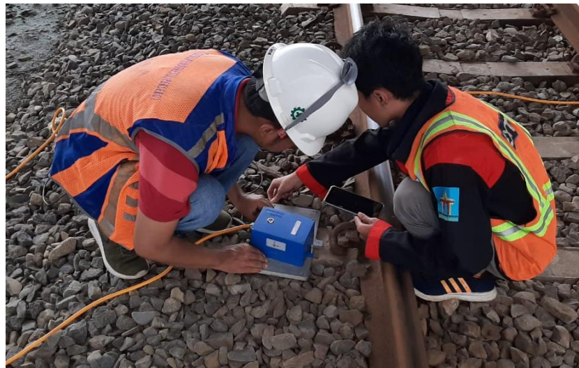
Gambar 3.7 Pemasangan sensor pada bantalan rel
