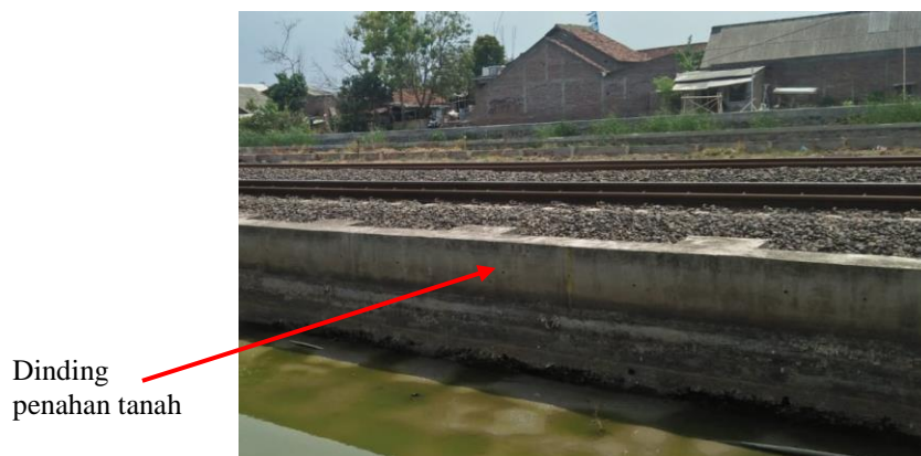
Gambar 2.15 Dinding penahan tanah pada jalan rel
