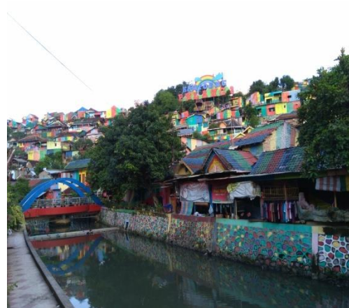
Talud Sungai Kampung Pelangi
