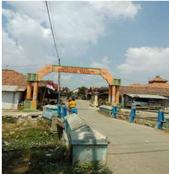
Gambar 4.5 Kondisi jalan di Desa Sumber : Dokumentasi Penelitian Tahun 2019
