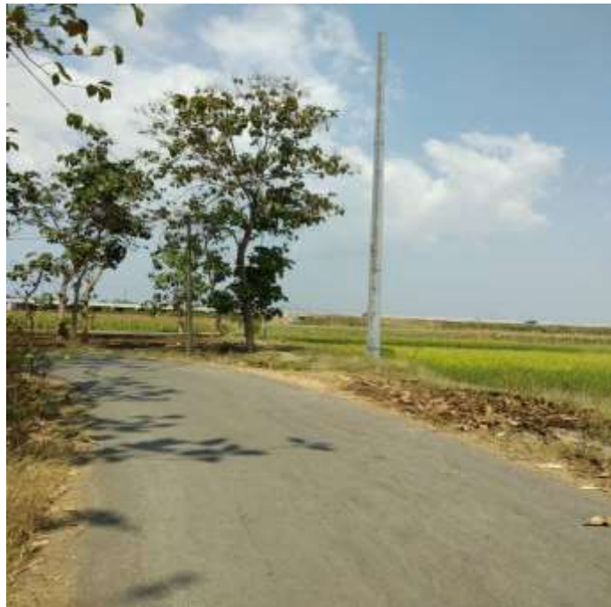
Gambar 4.3 Kondisi jalan di Desa Gembongdadi Sumber : Dokumentasi Penelitian Tahun 2019
