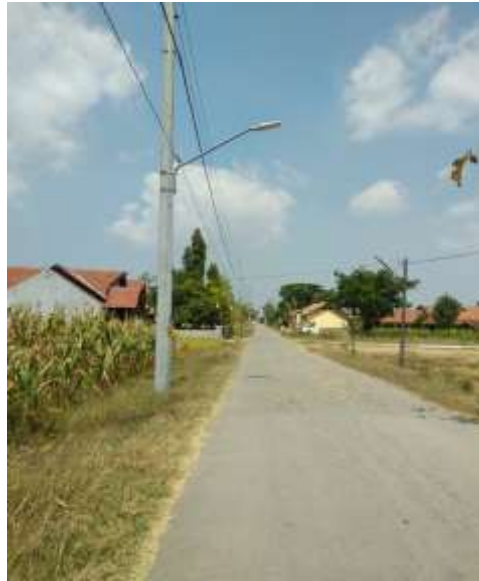
Gambar 4.9. Kondisi Jalan di Desa Sumber : Dokumentasi Penelitian Tahun 2019
