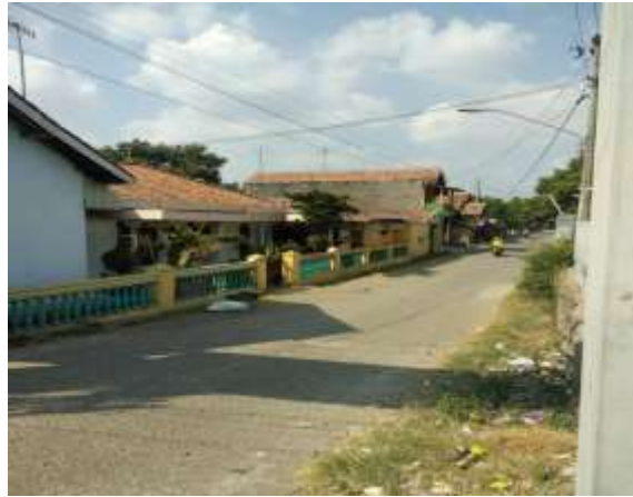
Gambar 4.10. Kondisi Jalan di Desa Sumber : Dokumentasi Penelitian Tahun 2019
