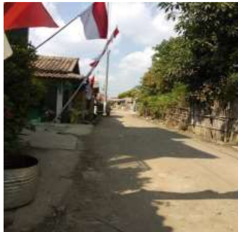
Gambar 4.11. Kondisi Jalan di Desa Sumber : Dokumentasi Penelitian Tahun 2019
