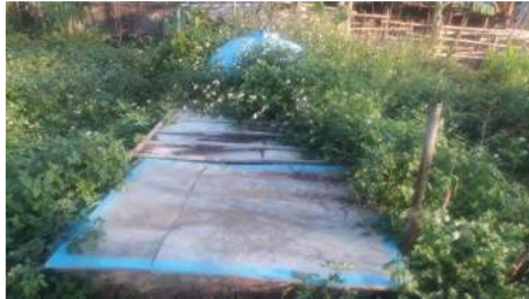
Gambar 4. 14 - Kondisi Alat Pembuatan Biogas
