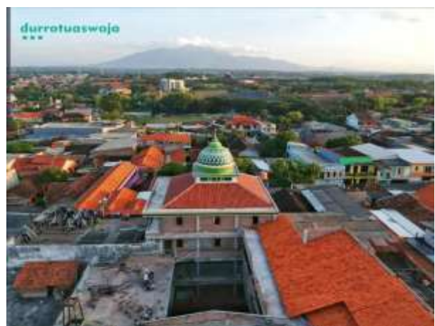
Gambar 3. Bangunan Pondok Pesantren Durrotu Aswaja Tampak Atas
