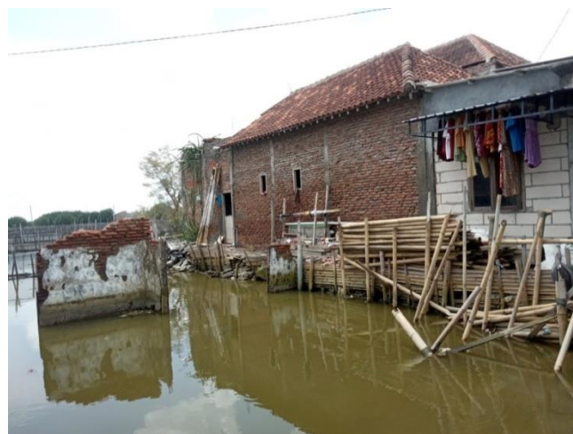
Gambar 4.30 Adaptasi proteksi secara fisik menggunakan dinding pantai untuk lingkungan tempat tinggal masyarakat di Dukuh Morosari Desa Bedono terhadap pengurangan daratan Sumber: Dokumentasi Lapangan, 2020
