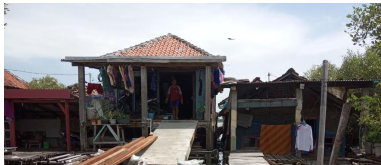
Gambar 4.38 Adaptasi akomodasi secara fisik untuk bangunan rumah dengan cara merubah konstruksi rumah menjadi rumah panggung, meninggikan bangunan rumah bata dan lantai rumah menggunakan polesan semen dan keramik di Dukuh Pandansari Desa Bedono Sumber: Dokumentasi Lapangan, 2020
