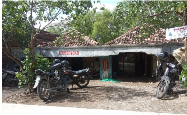
Gambar 4.37 Adaptasi akomodasi secara fisik untuk bangunan rumah dengan cara hanya meninggikan lantai rumah menggunakan padas di Dukuh Morosari Desa Bedono Sumber: Dokumentasi Lapangan, 2020
