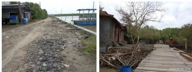
Gambar 4.47 Adaptasi akomodasi secara fisik untuk jalan lokal dengan cara meninggikan menggunakan padas dan kayu di Dukuh Mondoliko dan Dukuh Tambaksari Desa Bedono
