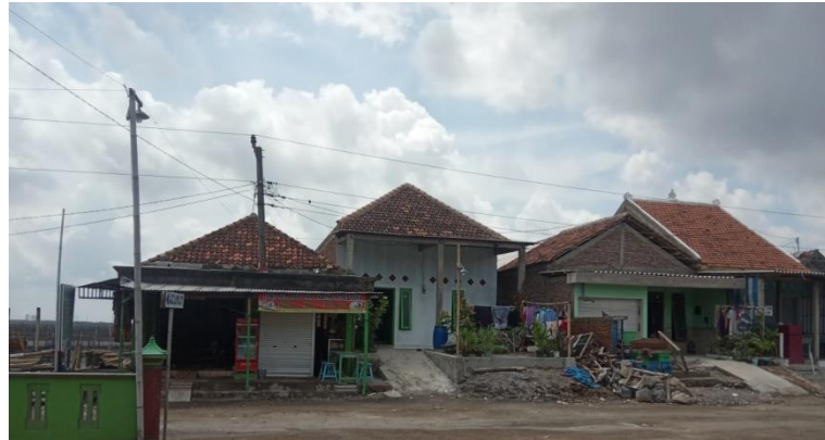
Gambar 4.35 Adaptasi akomodasi secara fisik untuk bangunan rumah dengan cara meninggikan bangunan rumah menggunakan bata dan lantai rumah menggunakan polesan semen dan keramik di Dukuh Morosari Desa Bedono
