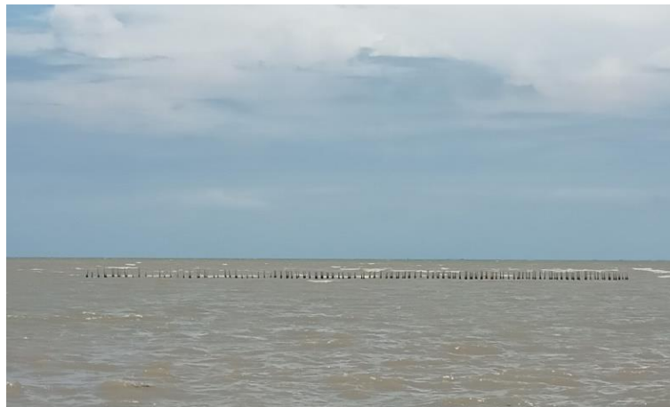
Gambar 4.26 Hybrid Engineering di Dukuh Bedono Desa Bedono yang tenggelam akibat kenaikan muka air laut Sumber: Dokumentasi Lapangan, 2020
