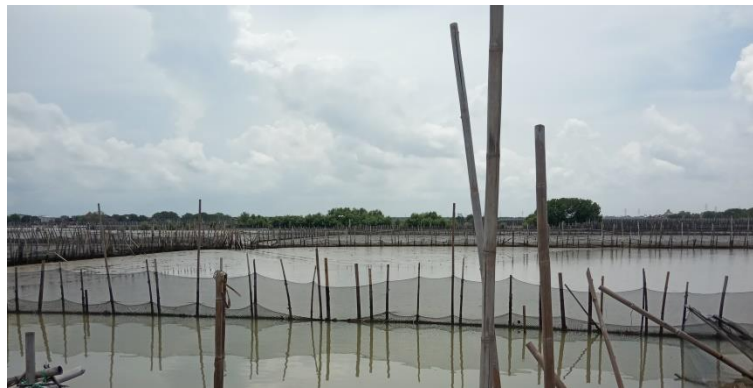
Gambar 4.33 Adaptasi proteksi secara fisik menggunakan waring untuk lahan tambak di Dukuh Pandansari Desa Bedono terhadap pengurangan daratan
