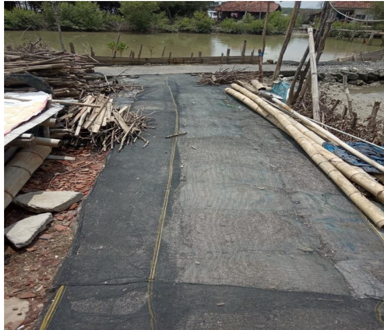
Gambar 4.42 Adaptasi akomodasi secara fisik untuk renovasi dan modifikasi halaman sekitar rumah dan jalan rumah dengan cara meninggikan menggunakan krasak di Dukuh Bedono Desa Bedono Sumber: Dokumentasi Lapangan, 2020
