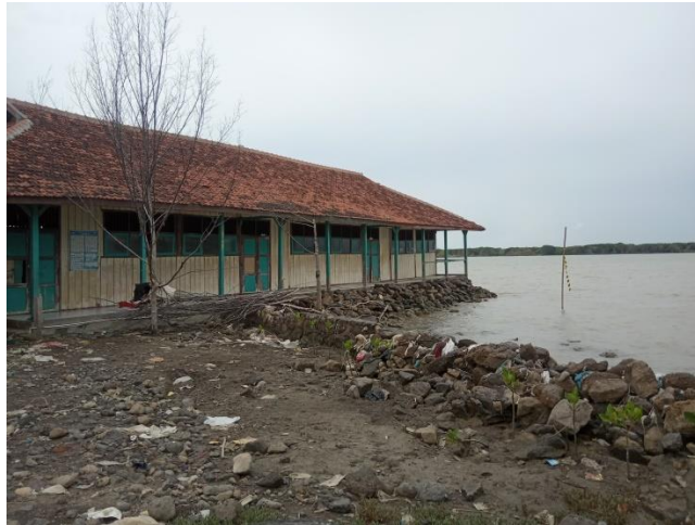
Gambar 4.28 Dinding pantai di SDN 1 Bedono Sumber: Dokumentasi Lapangan, 2020
