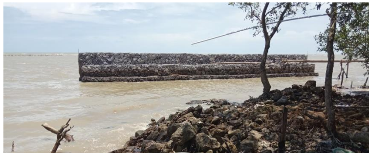
Gambar 4.25 Pemecah gelombang terbuat dari tumpukan batu dengan satu bangunan di Dukuh Bedono Desa Bedono Sumber: Dokumentasi Lapangan, 2020
