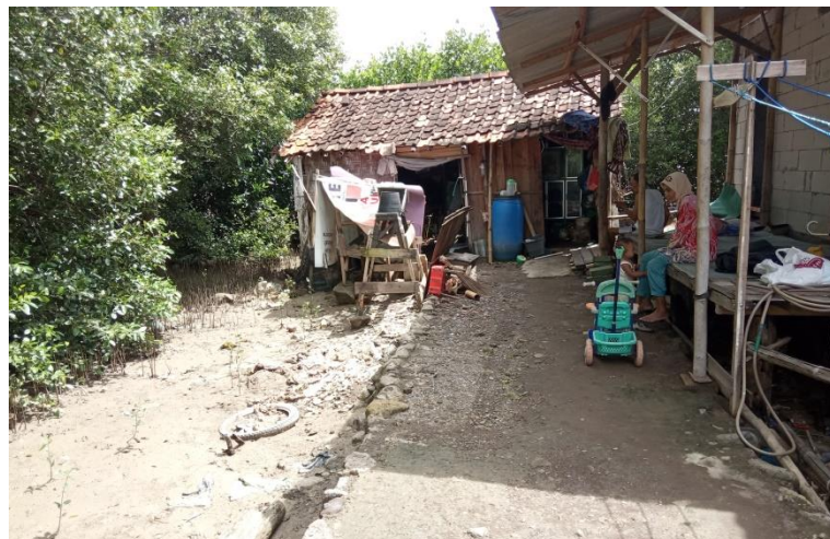
Gambar 4.43 Adaptasi akomodasi secara fisik untuk renovasi dan modifikasi halaman sekitar rumah dan jalan rumah dengan cara meninggikan menggunakan padas di Dukuh Morosari Desa Bedono Sumber: Dokumentasi Lapangan, 2020
