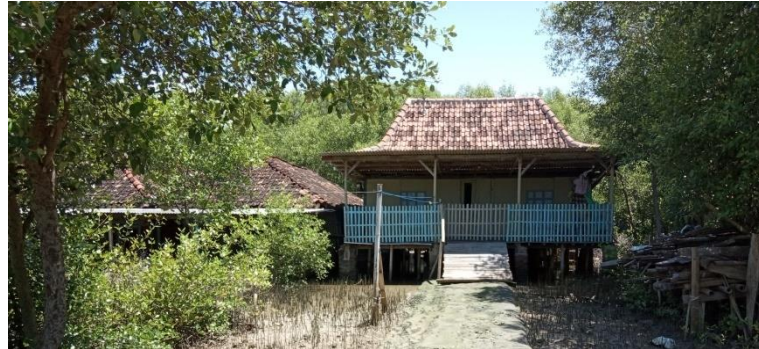
Gambar 4.40 Adaptasi akomodasi secara fisik untuk bangunan rumah dengan cara merubah konstruksi rumah menjadi rumah panggung, meninggikan bangunan rumah dan lantai rumah menggunakan kayu di Dukuh Bedono Desa Bedono Sumber: Dokumentasi Lapangan, 2020
