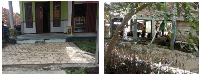
Gambar 4.39 Adaptasi akomodasi secara fisik untuk bangunan rumah dengan cara merubah konstruksi rumah menjadi rumah panggung, meninggikan bangunan rumah menggunakan bata dan lantai rumah menggunakan kayu di Dukuh Morosari Desa Bedono Sumber: Dokumentasi Lapangan, 2020
