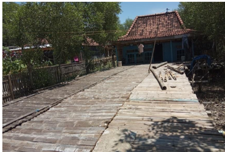
Gambar 4.41 Adaptasi akomodasi secara fisik untuk renovasi dan modifikasi halaman sekitar rumah dan jalan rumah dengan cara meninggikan menggunakan kayu di Dukuh Pandansari Desa Bedono
