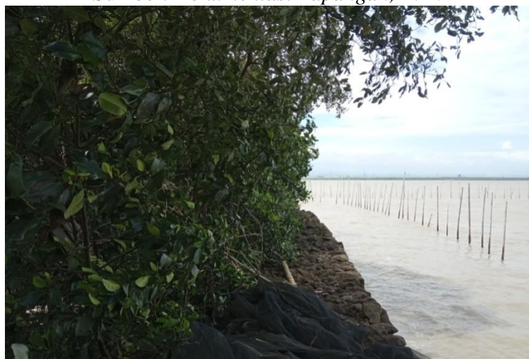
Gambar 4.20 Dinding pantai yang terbuat dari tumpukan batu di Dukuh Morosari Desa Bedono
