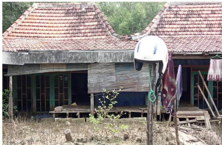
Gambar 4.36 Adaptasi akomodasi secara fisik untuk bangunan rumah dengan cara hanya meninggikan lantai rumah menggunakan kayu di Dukuh Mondoliko Desa Bedono
