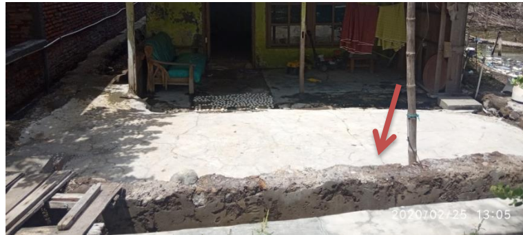
Gambar 4.44 Adaptasi akomodasi secara fisik untuk selokan dengan cara meninggikan di Dukuh Morosari Desa Bedono Sumber: Dokumentasi Lapangan, 2020
