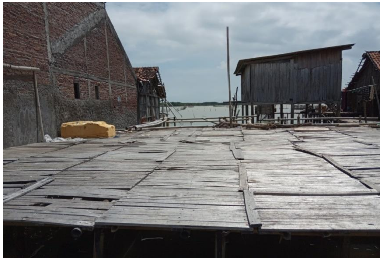
Gambar 4.56 Panggung yang dibuat responden untuk melakukan hajatan di Dukuh Pandansari Desa Bedono Sumber: Dokumentasi Lapangan, 2020
