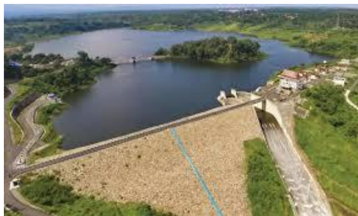
Gambar 4.1 Pintu Air di Waduk Jatibarang
