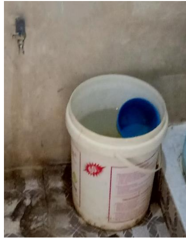
Gambar 4.15. Kondisi air di toilet ekowisata hutan mangrove Desa Pasarbanggi Rembang Sumber : Dokumentasi peneliti
