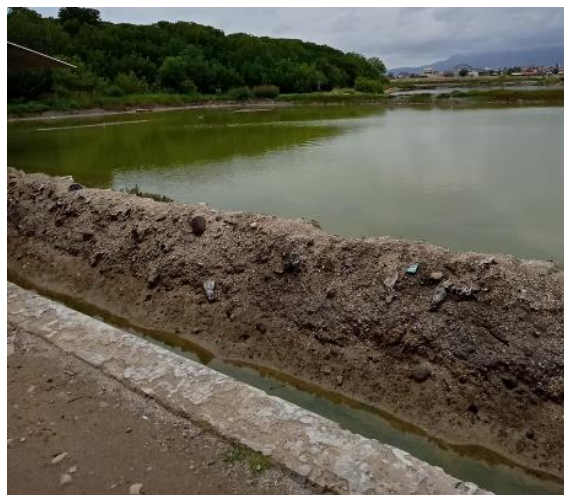
Gambar 4.16. Kondisi sanitasi di ekowisata hutan mangrove Desa Pasarbanggi Rembang
