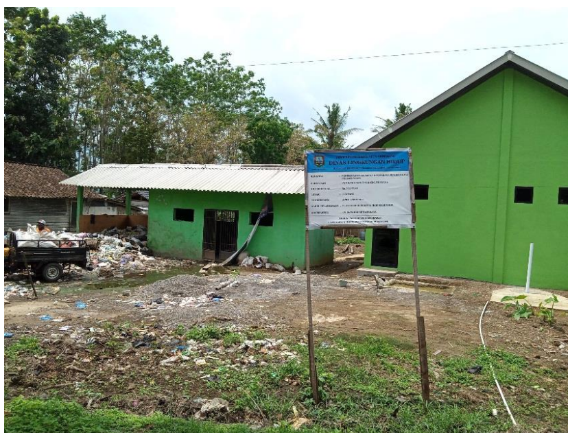
Gambar 11. Kondisi Bangunan TPS 3R Sumber: Dokumentasi Peneliti pada 2 Maret 2020
