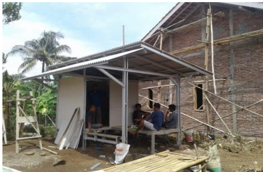
Gambar 6. Pembangunan Rumah Tidak Layak Huni di Dusun 1. Sumber: Data Sekunder, 2019.
