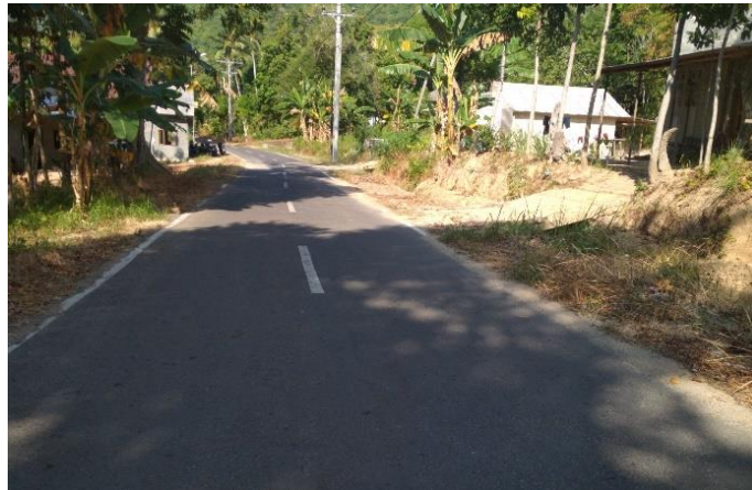
Gambar 3.26 Akses jalan alternatif tapak 3
