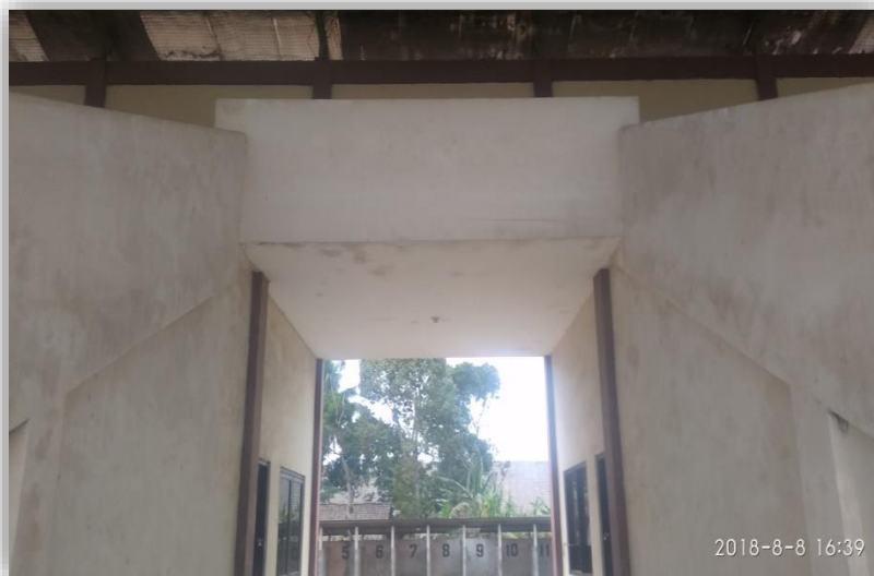
Gambar 3.26 Entrance karcis Sumber: Dokumentasi penulis, 2018
