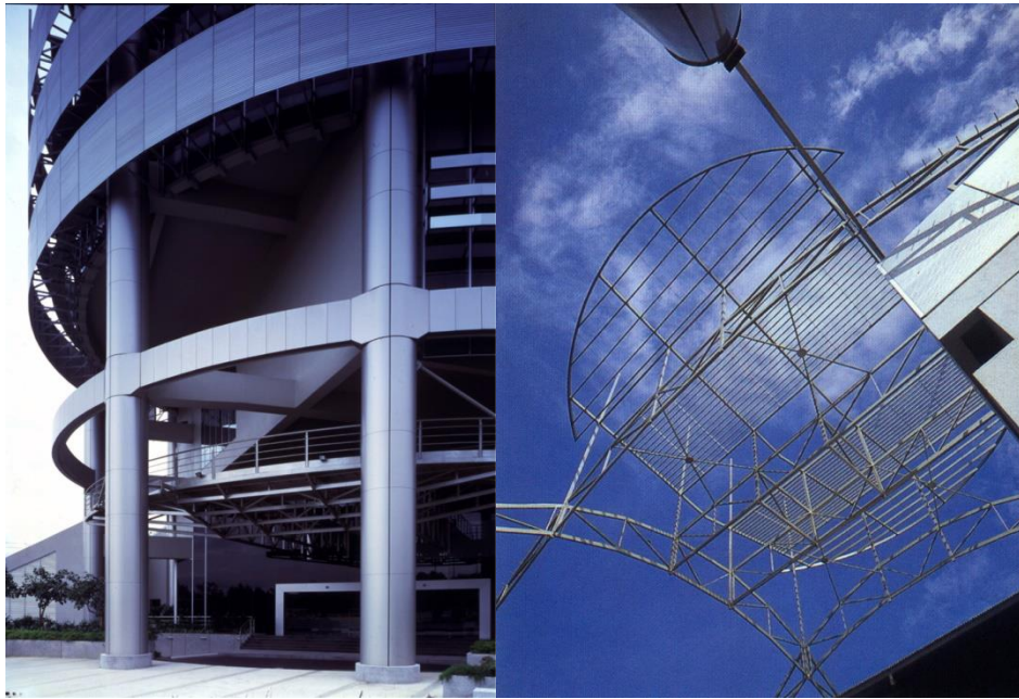
Gambar 2.52 fasad mesniaga dan instalasi fotovoltaiik
