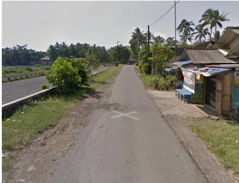
Gambar 3.3 Kondisi Jalan Sumber: Google Earth, 2018
