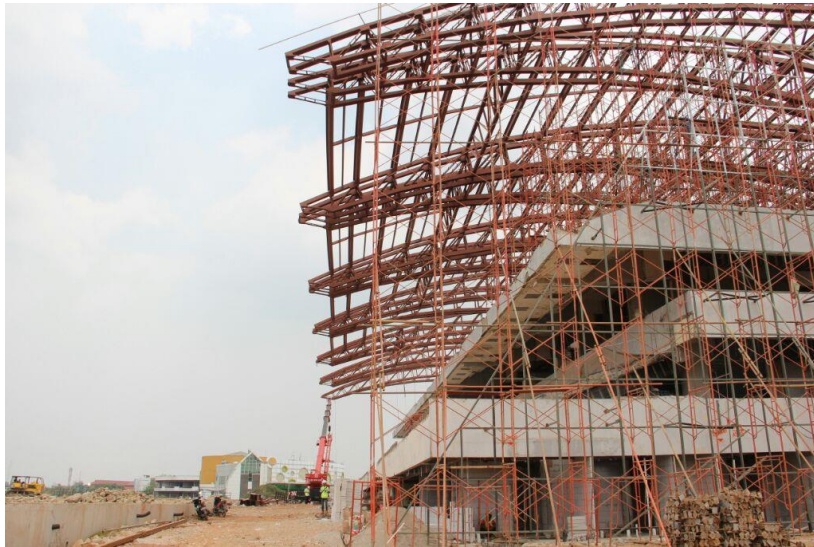
Gambar 3.36 Pengerjaan bangunan JEIP
