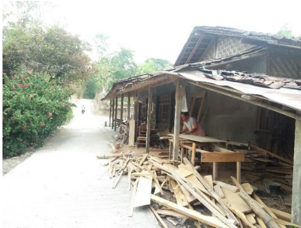
Gambar 3. 46 Batas Site Arah Barat
