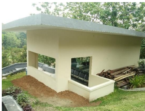
Gambar 3. 23 Bangunan Museum Dengan Atap Dak
