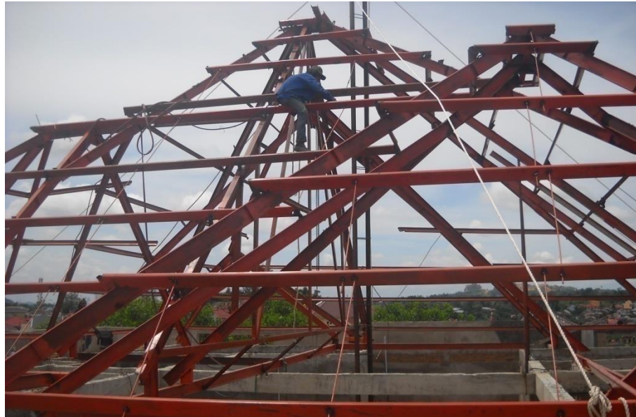
Gambar 4.24 Rangka Atap Baja Konvensional
