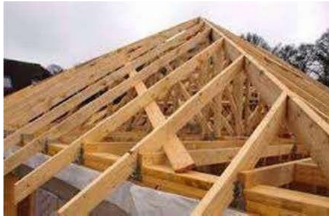
Gambar 4.25 Struktur Atap Kayu Sumber : rumahhuni.com
