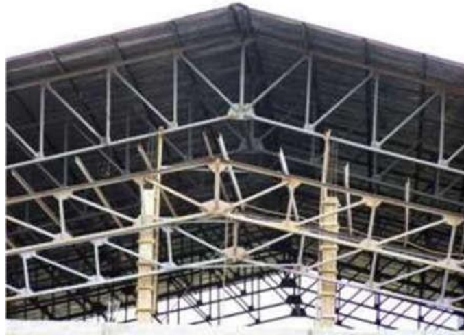
Gambar 4.23 Struktur Atap Baja Sumber : desainkonstruksibaja.blogspot.com
