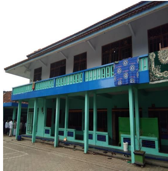
Gedung Kamar Pondok
