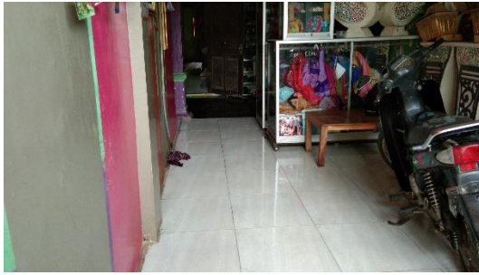
Kondisi lantai rumah responden kontrol
