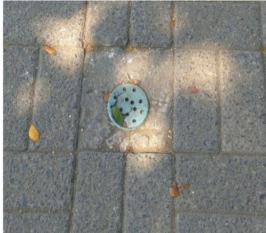
Gambar 4.32 Lubang biopori di halaman sekolah
