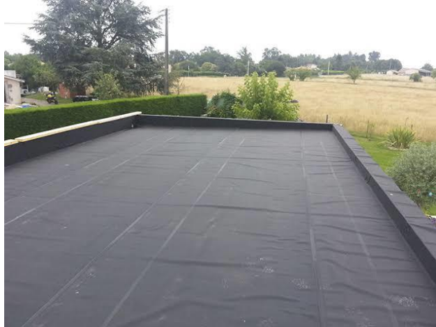
Gambar 3.2 Pelapis Atap Membran EPDM Sumber: www.rubberlinninandsheeting.com
