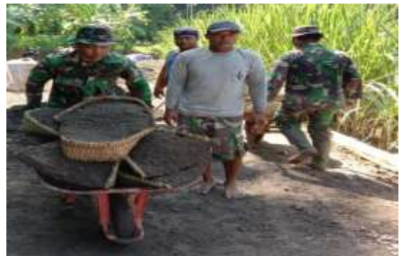
Gambar 7 Para tukang bangunan berusaha mendorong pasir menggunakan gerobak dorong
