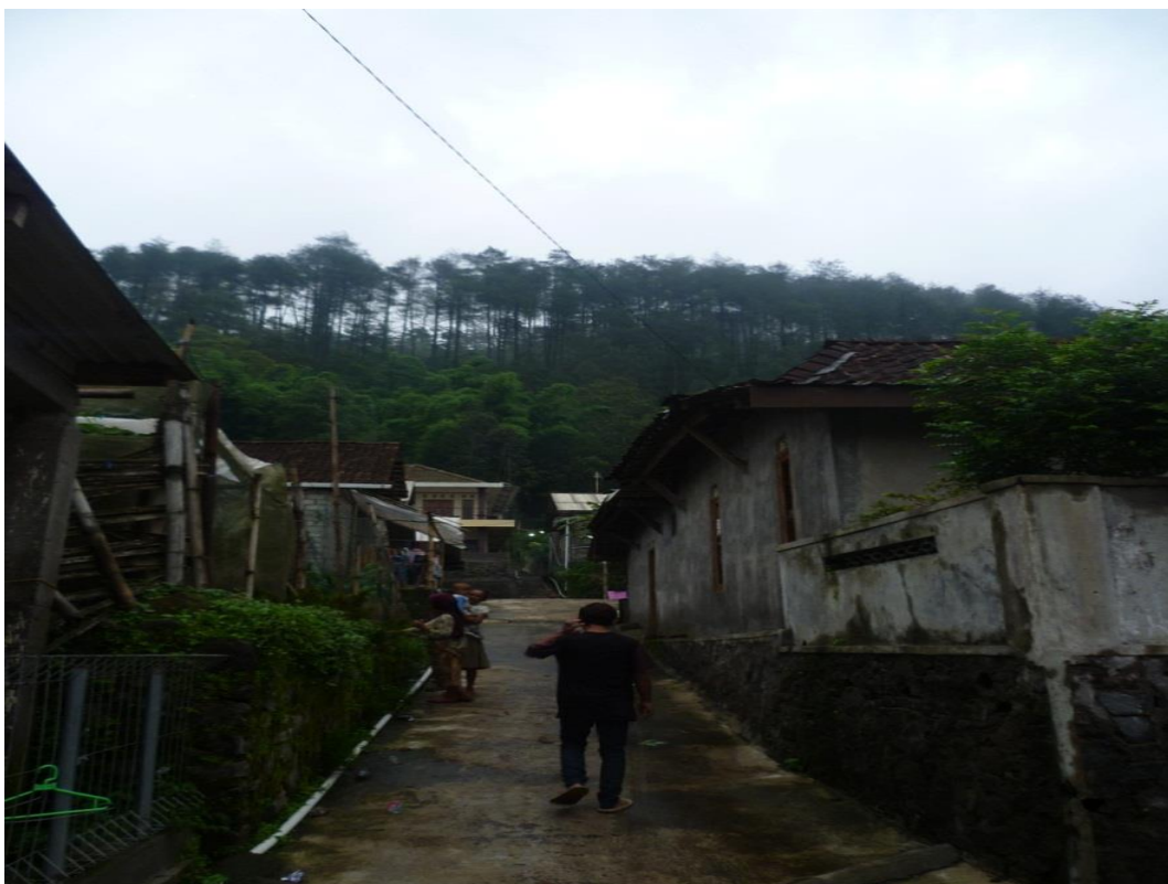
Gambar 76. Keadaan Rumah Terdampak Longsor di Desa Batur
