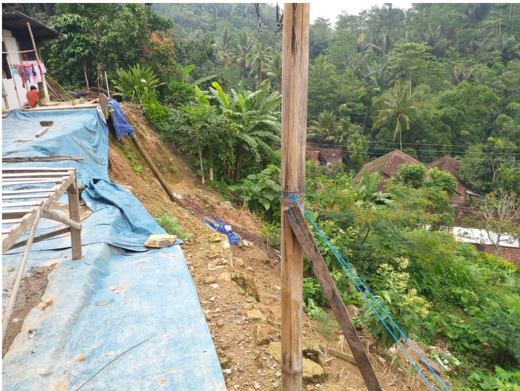
Gambar 82. Keadaan Rumah Warga Terdampak Longsor di Desa Tegaron
