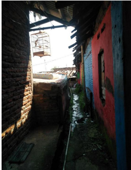
Gambar 4. 18 Kondisi Rumah di Kampung Pelangi
