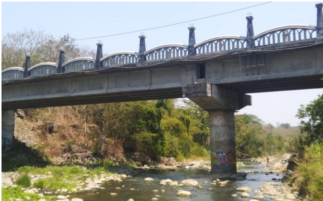
Pilar Jembatan Tinjomoyo
