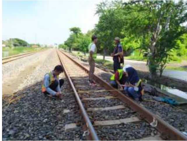
Gambar 4.3 Pengukuran Dimensi Rel
