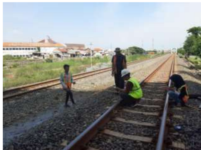
Gambar 4.5 Pengukuran Dimensi Ballast
