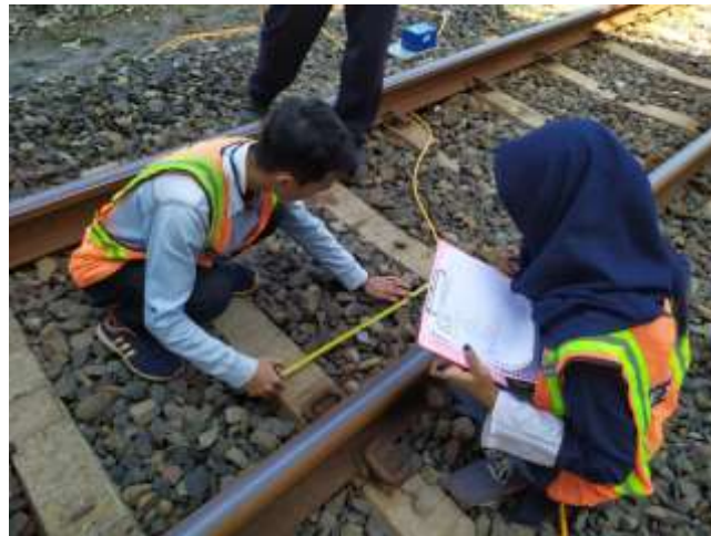
Gambar 4.4 Pengukuran Dimensi Bantalan
