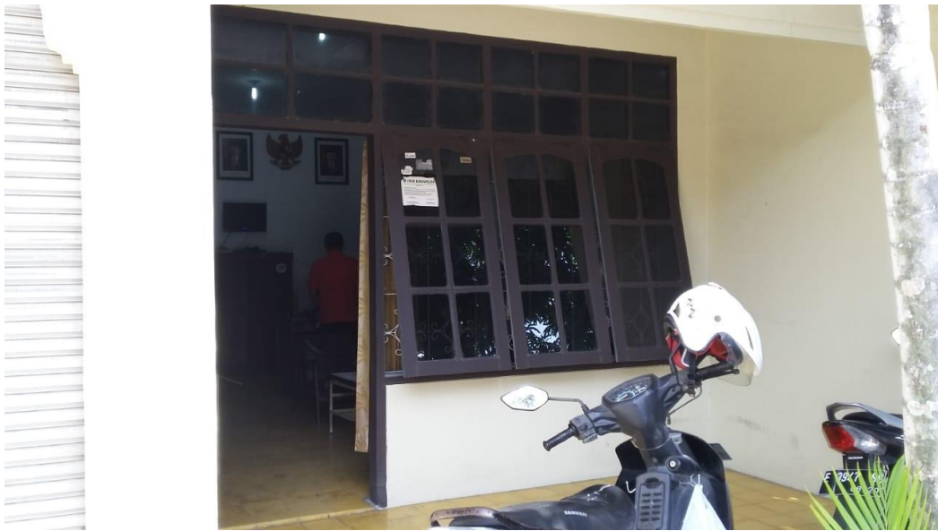
Foto Lampiran 7 : Tampak depan kantor Tata Usaha GKI Indramayu, Alberta, dokumentasi pribadi (diambil pada 12 April 2019)
