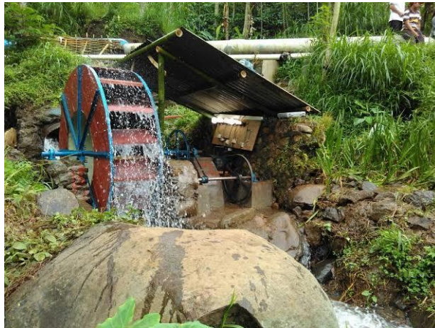
Gambar 2. Pembangkit listrik tenaga air
