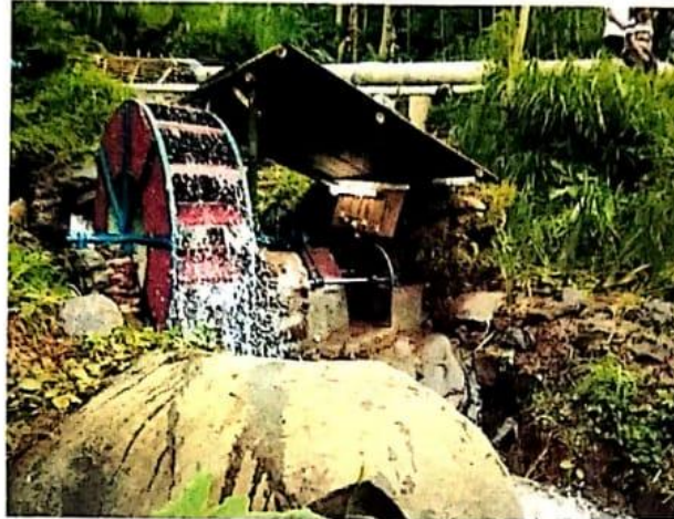
Gambar 2. Pembangkit listrik tenaga air
