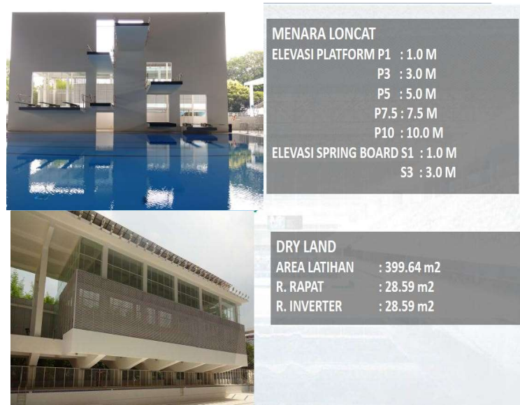
Gambar 2.24 Data Menara Loncat dan Dry Land Stadion Akuatik GBK Sumber: dokumen PPK-GBK
