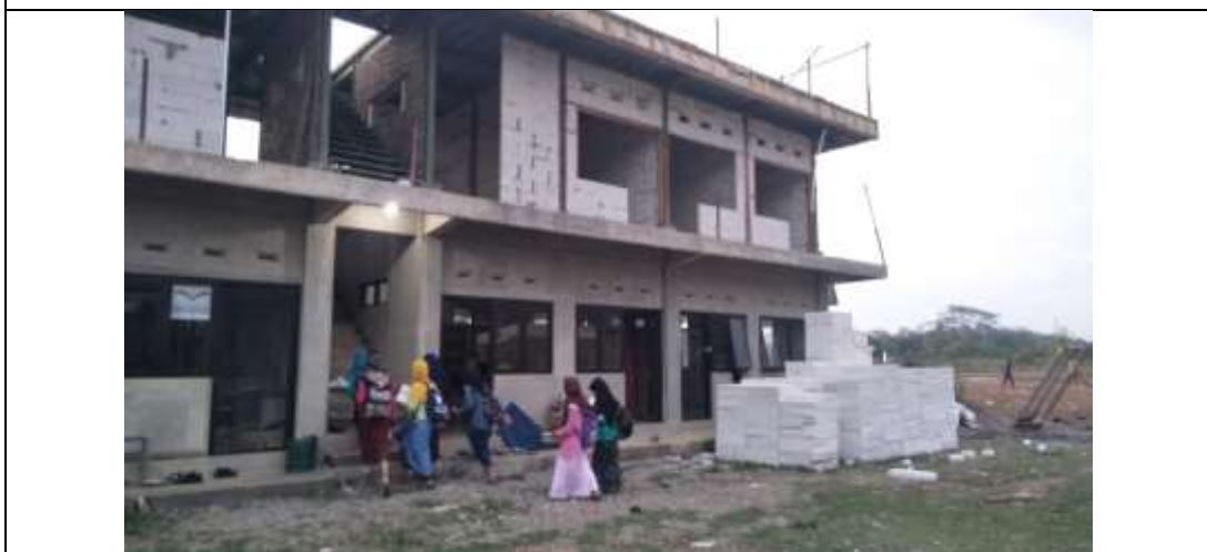
Gambar 2. Asrama Putra dan Ruang Kelas (dalam Pembangunan)
